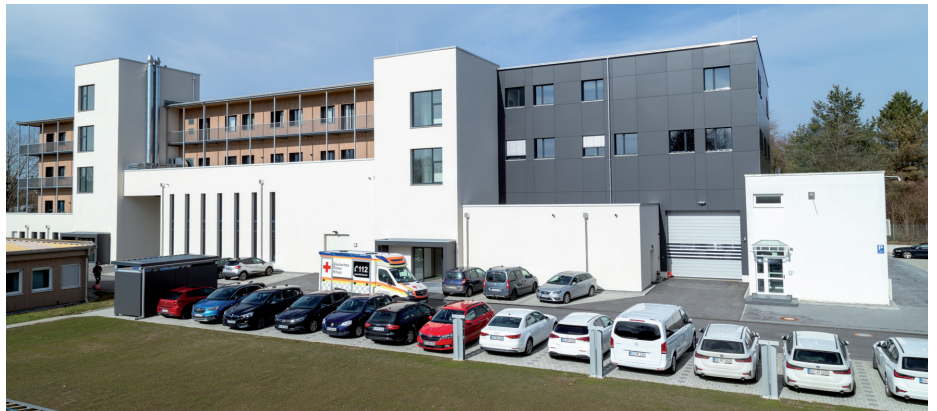
Zukunftssichere Versorgung mit Wärme und Strom für Verwaltungsgebäude und Rettungswache
